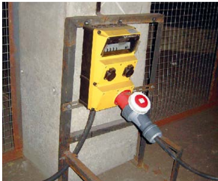
Казанский метрополитен, перегонный тоннель / Россия
