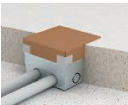
Нанесение стяжки Нанести стяжку вокруг лючка. Не рекомендуется использовать разделительную прокладку.
