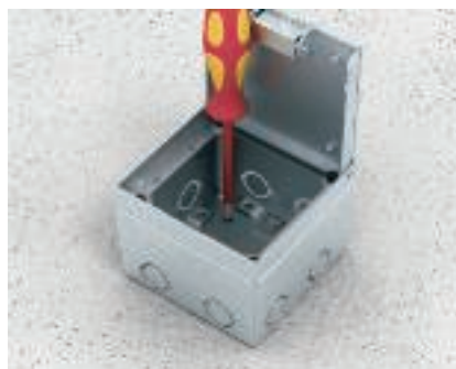
Монтаж на несущем перекрытии Закрепить лючок на несущем перекрытии.
