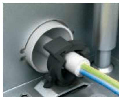
Монтаж фиксатора для разгрузки кабеля от натяжения Установить фиксатор для разгрузки кабеля от натяжения перед введенной электро-монтажной трубой (для подключения розетки).
