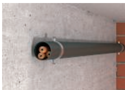
Прокладка нескольких кабелей по данным сертификатов об испытаниях
