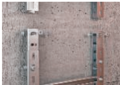
Стык с соединителем
