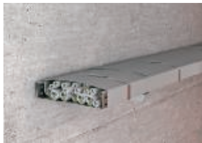
Полная обмотка кабельной трассы, настенный монтаж
