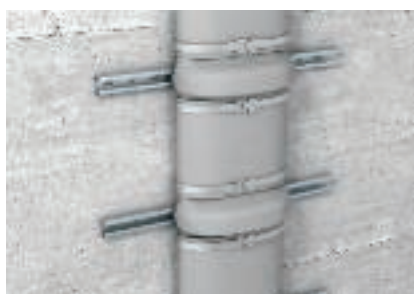
Крепление бандажа металлическими монтажными лентами при монтаже профильных реек
