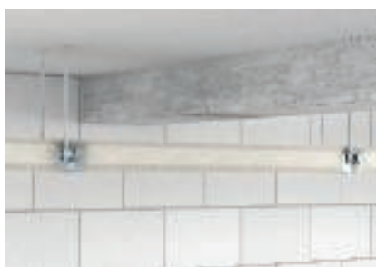
Подвесной монтаж на соединительных элементах
