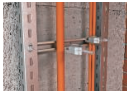
Монтаж кабеля с зажимными скобами, также возможен при последующей прокладке
