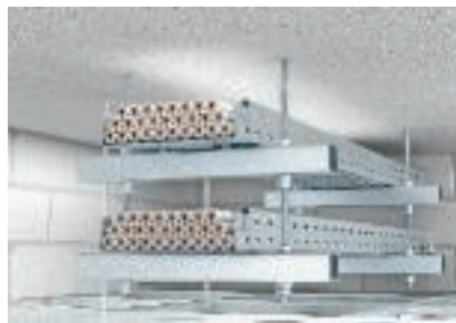
Двухуровневый потолочный монтаж над подвесным огнестойким потолком
