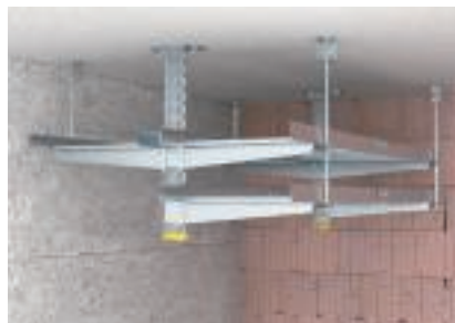
Потолочный монтаж с кронштейнами, расположенными с обеих сторон
