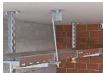
Крепление стержня с резьбой в огнестойкой скобе
