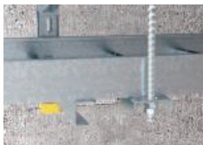
Соединительная деталь на расстоянии не более 100 мм рядом с кронштейном
