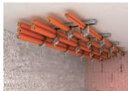
Горизонтальный монтаж кабеля зажимными скобами под потолком
