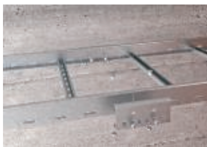
Монтаж продольных соединителей винтами с полукруглыми низкими головками
