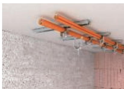
Монтаж отдельного кабеля или пучка кабелей
