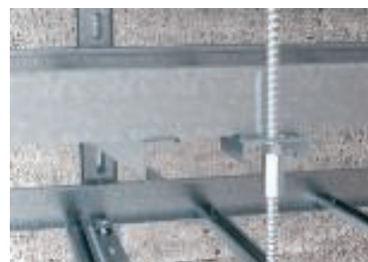
Монтаж резьбового стержня при многоуровневой прокладке трасс
