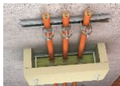
Эффективное средство для разгрузки кабеля от натяжения ZSE90
