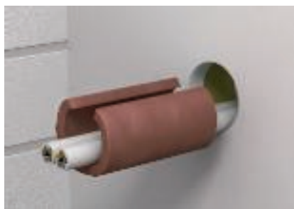
Если кабель уже проложен, то необходимо надрезать огнестойкую оболочку
