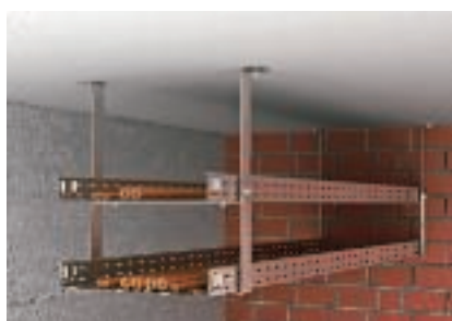
Двухуровневый потолочный монтаж с навесной скобой и удлинителем
