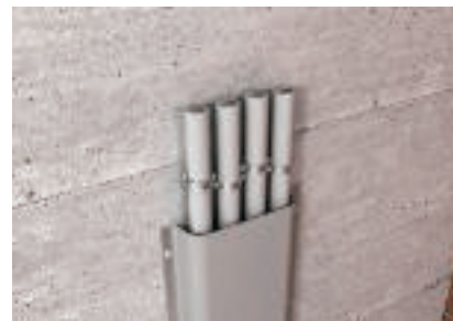
Крепление бандажа металлическими шинами при монтаже дистанционных скоб
