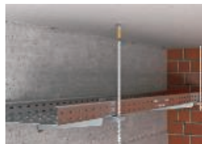
Потолочное крепление стержней с резьбой с дюбелем с внутренней резьбой
