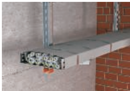
Полная обмотка подвесной кабельной трассы
