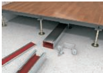
Монтаж на сыром бетоне в полу
