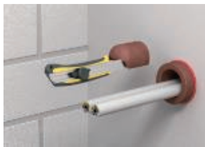
Обрезать огнестойкую заглушку по размеру и вставить в оболочку
