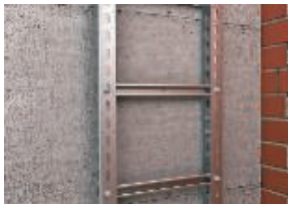
Настенный монтаж вертикальной трассы к монолитной стене
