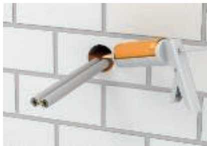
Заполнение отверстий шпатлевкой FBA-SP
