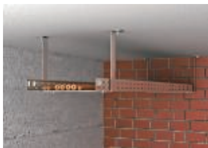
Одноуровневый потолочный монтаж с навесной скобой
