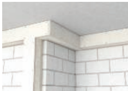
Гибкое расположение короба обеспечивается индивидуальными фасонными деталями
