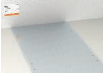
Невидимая проходка в коробах для скрытого подпольного монтажа в бесшовном полу
