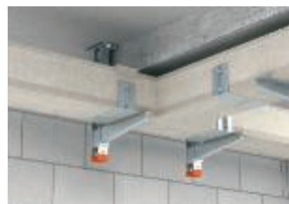
Предварительно смонтированные стандартные фасонные детали в трассах
