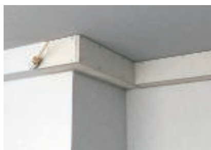
Завершающая обработка поверхности: нанесение краски или наклеивание обоев
