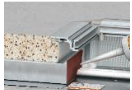
Заделать стыки между кабелями и блоками шпатлевкой FBA-SP
