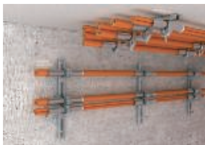
Горизонтальный монтаж с зажимными скобами и продольными пластинами на стене и под потолком
