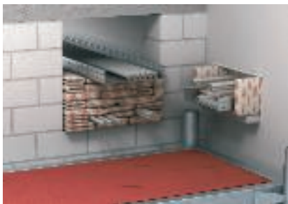
Отверстие заполняется подушками без шпатлевки или окраски
