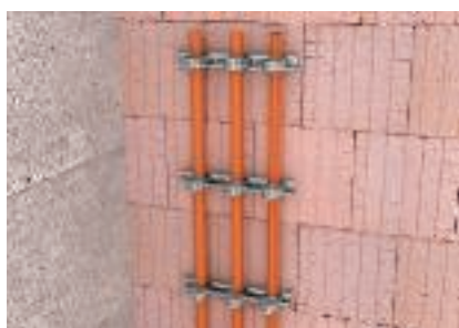
Вертикальный монтаж кабеля зажимными скобами на стене
