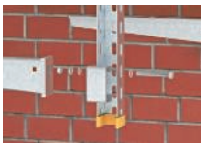
Монтаж кронштейна с дистанционной вставкой и винтом с шестигранной головкой
