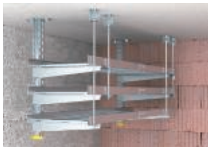
Потолочный монтаж с кронштейнами, расположенными с одной стороны
