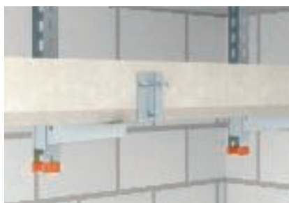
Надежное стыковое соединение в результате крепления предварительно смонтированной обшивки
