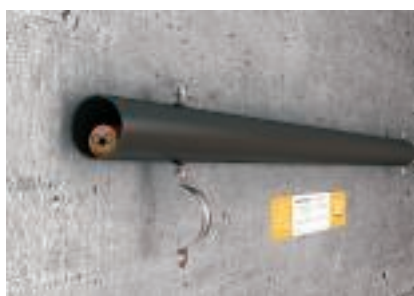
Ввод в резьбовую скобу с оттоком от стены, зацепив крышку под винтом
