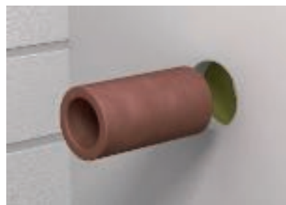
Вставить огнестойкую оболочку в отверстие в перегородке
