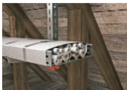
Бандажированные кабеленесущие системы в областях с большим количеством воспламеняющихся материалов
