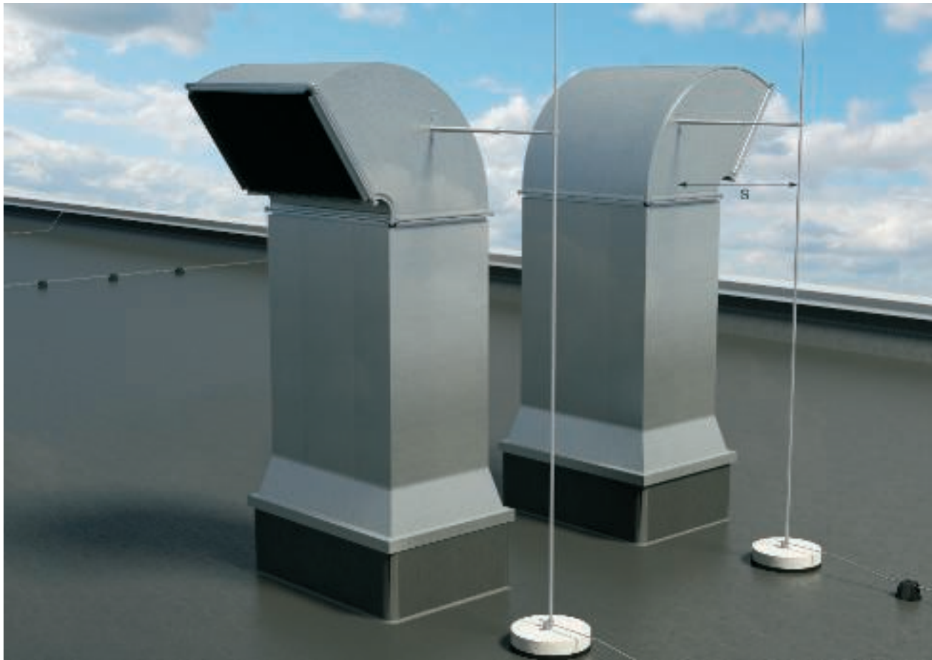
Молниеприемный стержень, установленный с помощью комплекта Iso-Combi, с соблюдением разделительного интервала (s)
