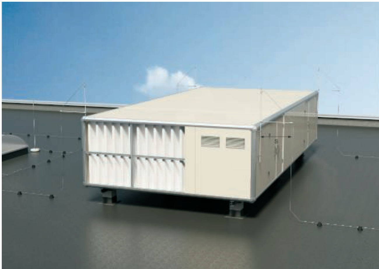
Изолированные молниеприемные устройства с разделительным интервалом (s)
