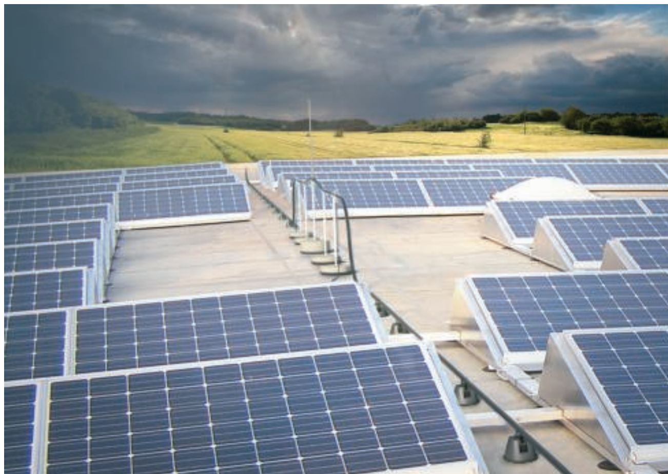
Плоская кровля с фотогальванической установкой, защищенной изолированным отводом isCon®
