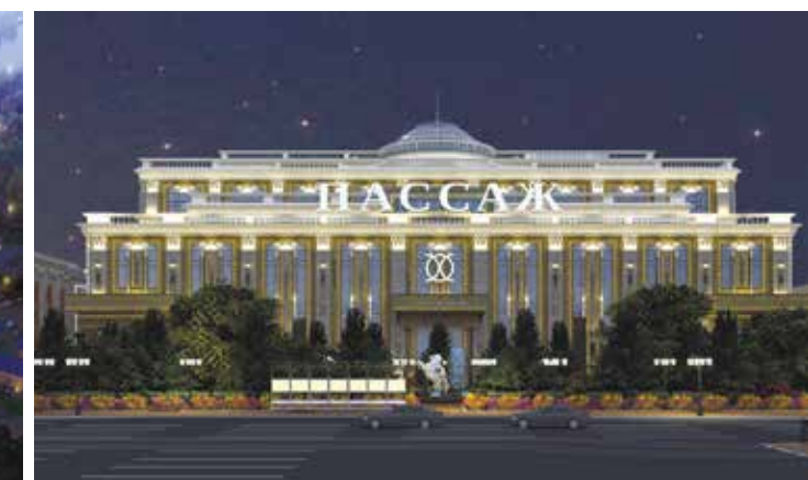
ТРЦ «Пассаж», г. Екатеринбург Установленные системы: ПС, АДУ, ПТ, RVi
