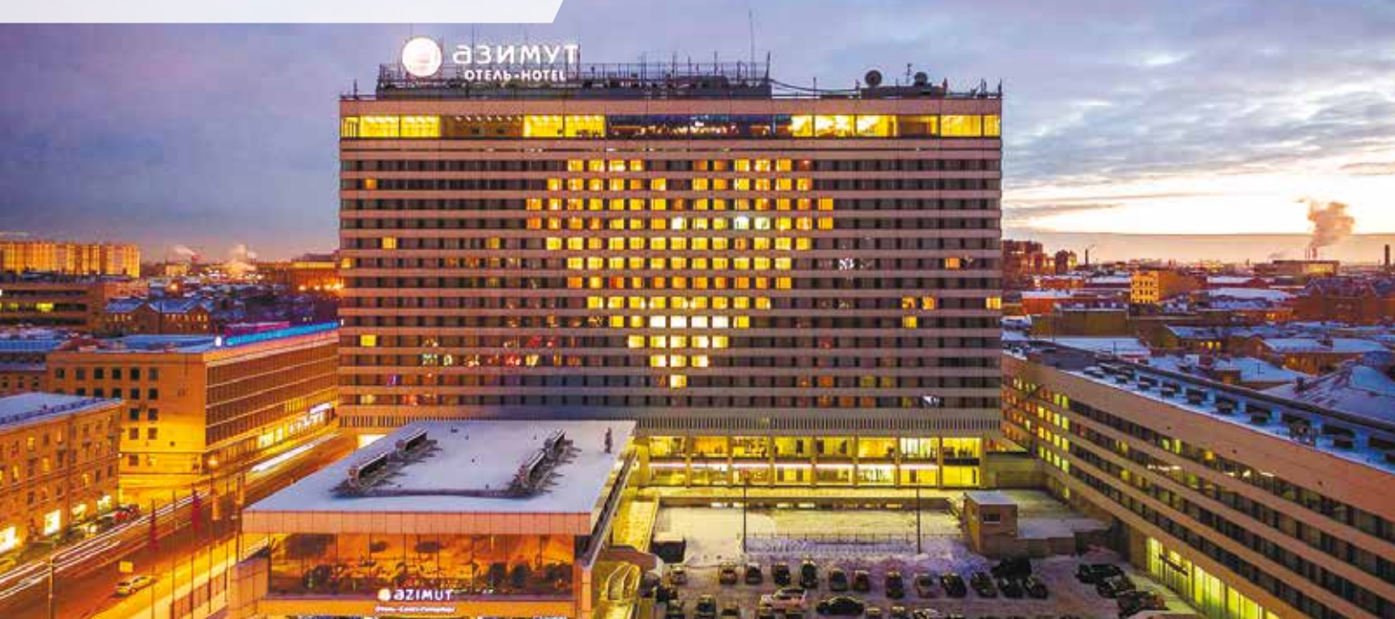
гостиница «Азимут», г. Санкт-Петербург Установленные системы: ПС, АДУ
