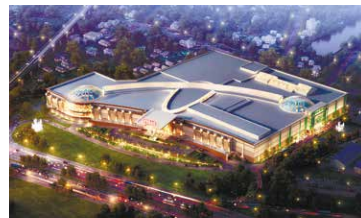
ТРК «Вегас», г. Москва Установленные системы: АПС, АДУ
