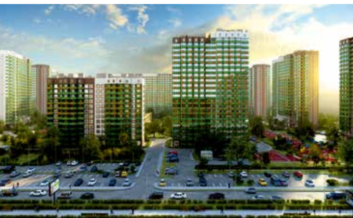
ЖК «ГринЛандия», г. Санкт-Петербург Установленные системы: ПС, АДУ, СОУЭ, АПТ
