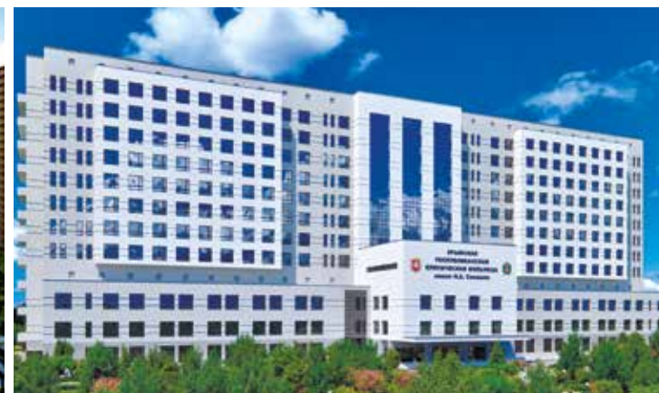
Республиканская клиническая больница им. Семашко, г. Симферополь Установленные системы: ПС, СОУЭ
