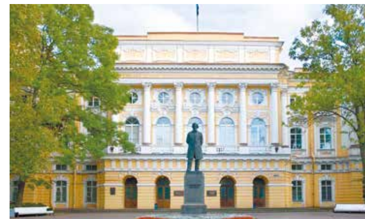
РГПУ им. П.А. Герцена, г. Санкт-Петербург Установленные системы: ПС, АДУ
