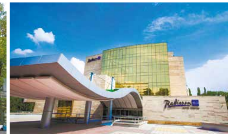
гостиница «Radisson Blu Yerevan», г. Ереван Установленные системы: СОУЭ
