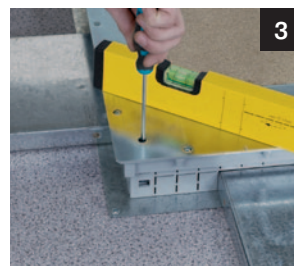
3 При помощи регулировочных винтов выставить уровень
