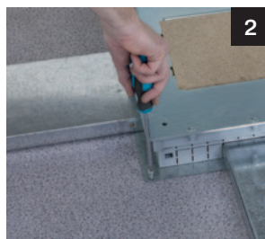
2 Закрепить коробку на полу
