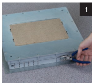
1 Завести в люк кабели, гофрированные трубы, лотки
