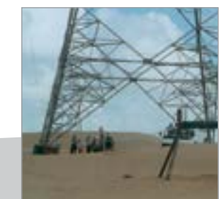
Проектирование и монтаж
