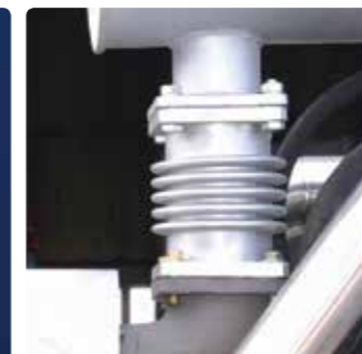
Сильфонный компенсатор
